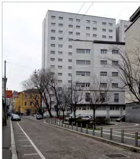
LE DUE ALI DEL COMPLESSO LUNGO VIA CORRIDONI (FOTO DI STEFANO SURIANO)
