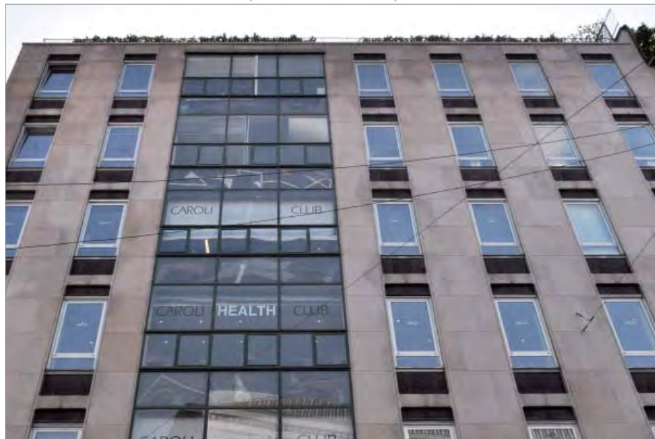
VISTA DAL BASSO DEL FRONTE SU VIA SENATO (FOTO DI STEFANO SURIANO)
