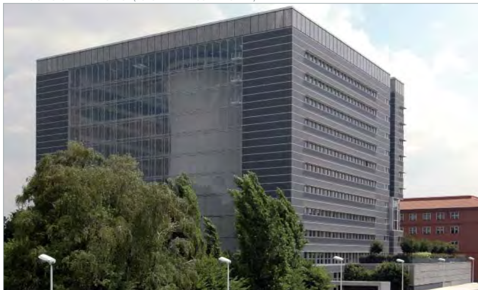
L'EDIFICIO VISTO DA VIALE SARCA (FOTO DI FEDERICO BALESTRINI)
