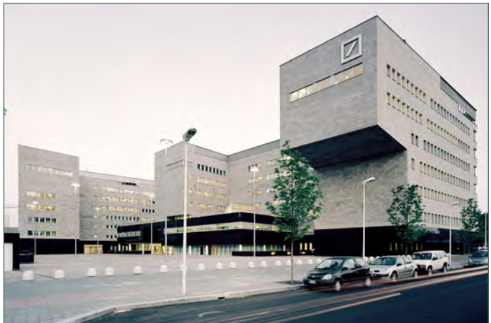
LE SEDE DELLA DEUTCHE BANK ALLA BICOCCA, OPERA DELLO STUDIO VALLE (FOTO GENTILMENTE CONCESSA DALLO STUDIO VALLE)
